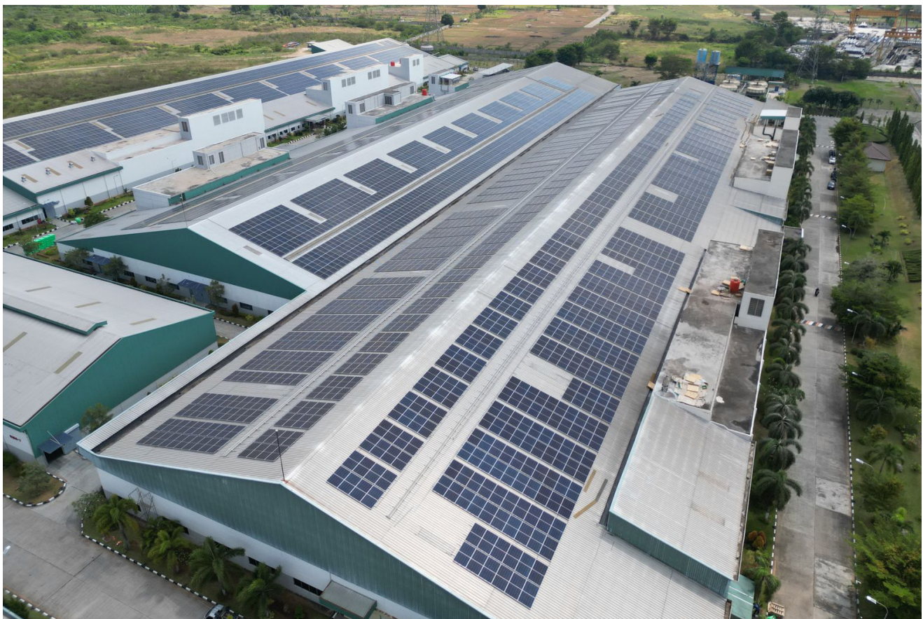
Roof Top Solar Panels for Renewable Electricity Generation Atap Panel Surya untuk Pembangkit Listrik Terbarukan
